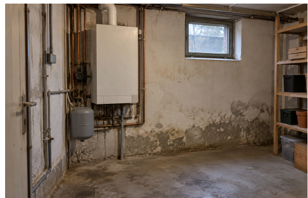
Keller mit Heizung, Sockelfeuchte Musterfoto
