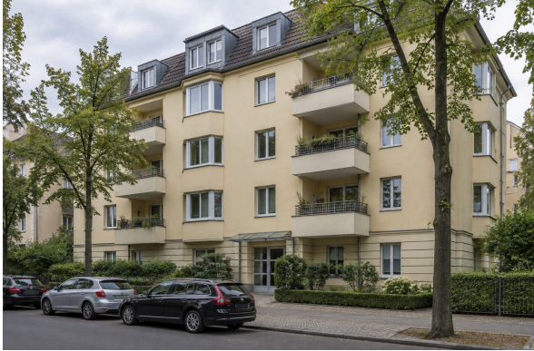
Ansicht des Gebäudes von der Straße
