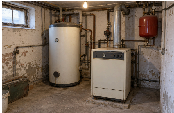
Heizungsanlage (Niedertemperaturkessel 1994)
